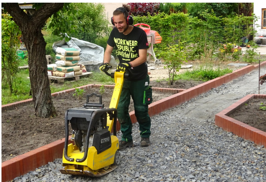
Nicolas beim Rütteln des neu entstehenden Gartenweges – mit solchen Maschinen macht die Arbeit doppelt Spaß.
